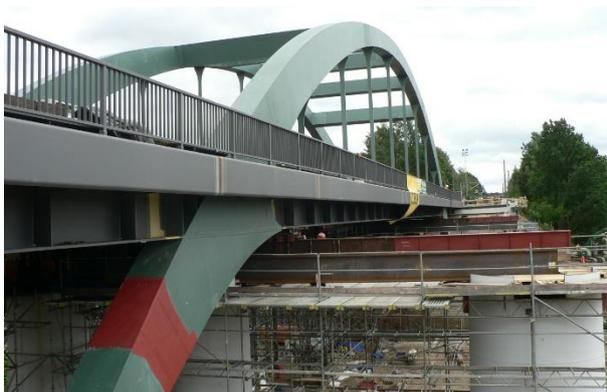
Zum Erhalt der Streckenverfügbarkeit der Eisenbahnstrecke 6255 Riesa - Chemnitz wird bei km 54,450 die Erneuerung der Eisenbahnüberführung Ottendorfer Viadukt geplant. Beim bestehenden eingeschossigen Viadukt aus dem Jahre 1852 waren aufgrund des schlechten Bauzustandes Sanierungsmaßnahmen ausgeschlossen. Damit war ein Abbruch mit anschließendem Ersatzneubau notwendig.
