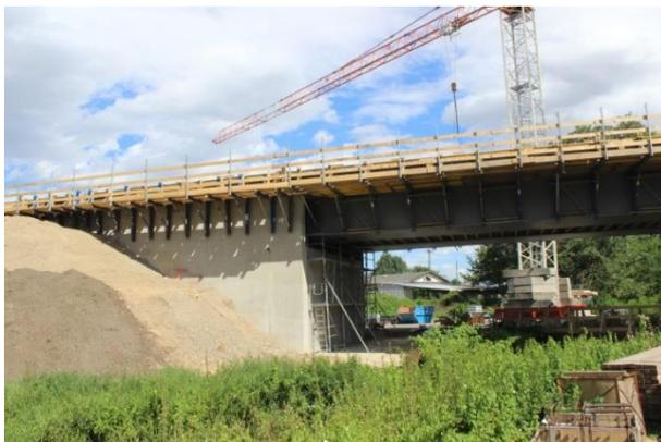
Mit dem Ausbau der Strecke 6248 Dresden – Elsterwerda war der Abschnitt Abzw Kottewitz (a) – Großenhain Berliner Bf (a) komplett zu erneuern. Aufgrund einer neuen Linienführung für  $v=200$  km/h resultiert das Erfordernis, die vorhandene EÜ über die Röder aus dem Jahr 1900 abzurechen und durch einen Neubau zu ersetzen.
