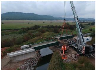
Bei km 9,180 wird die eingleisige Strecke 6302 Wolkramshausen – Erfurt zwischen den Gemeinden Großfurra und Sondershausen über den Fluss Wipper überführt. Die bestehende Eisenbahnüberführung aus dem Jahre 1869 befand sich in einem schlechten Zustand, weshalb ein ein Ersatzneubau an gleicher Stelle geplant wurde.
