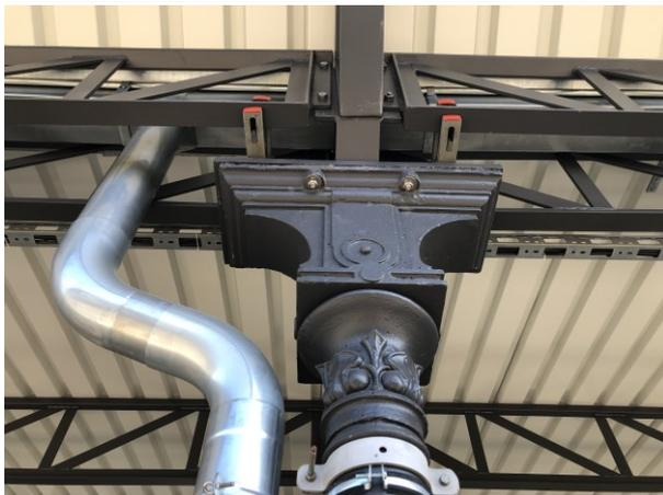
Im Zuge der Sanierung des Bahnhofsgebäudes am Bahnhof Bautzen wurde das Dach am Bahnsteig 1 erneuert. Der Ersatzneubau orientiert sich an der Bestandskonstruktion und wurde daher als Fachwerkkonstruktion ausgeführt.
